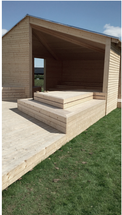
Pavillion i Jordrup Bypark. Landsbypuljen har betalt materialer og arbejdet er udført af elever fra Hansenberg.
